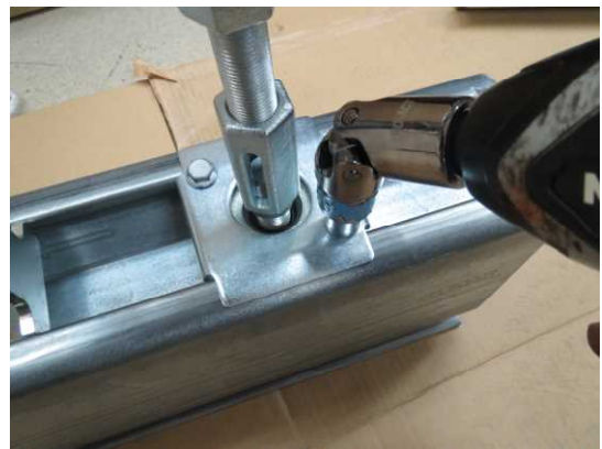
HB150S プロファイルコネクションのボルト 取付 (ユニバーサルジョイント使用)
