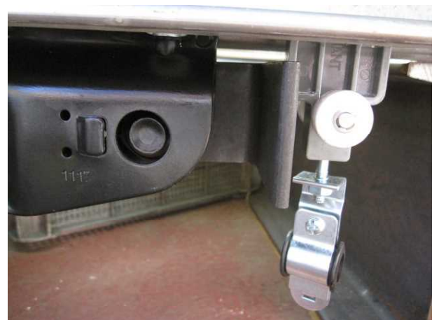
レールへの取り付け状況
