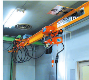
▲天井クレーンミニサドルにセット
