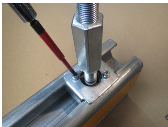
HB110S プロファイルコネクションのボルト取 付 (ボールポイントビット使用)
